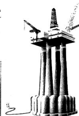
platforma grawitacyjna, spoczywająca na dnie swoją potężną masą;
