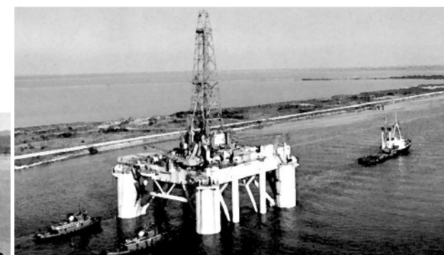
powyżej: holowanie platformy pływającej do miejsca pracy; po lewej: przygotowanie platformy lewarowej do holowania na miejsce przeznaczenia;
